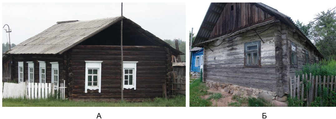
Рис. 4. Дома с полустропильной крышей (фото Л.А. Аболиной):
